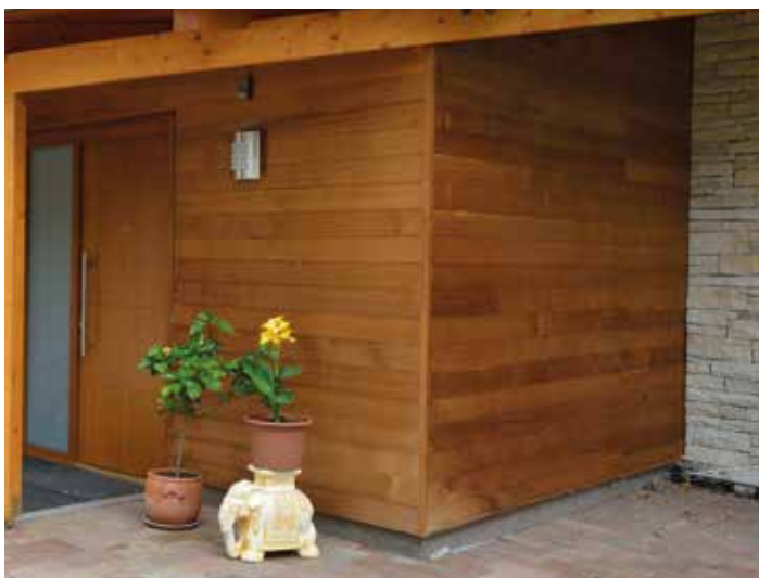
Fasáda REAL FACADE Západní červený cedr, profil klasický 17,5 x 137 mm, ponecháno přirodní
